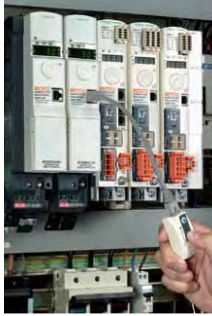
Simple-Loader aynı özellikteki bir sürücüden diğerine en hızlı şekilde konfigürasyon yükleyebilme
